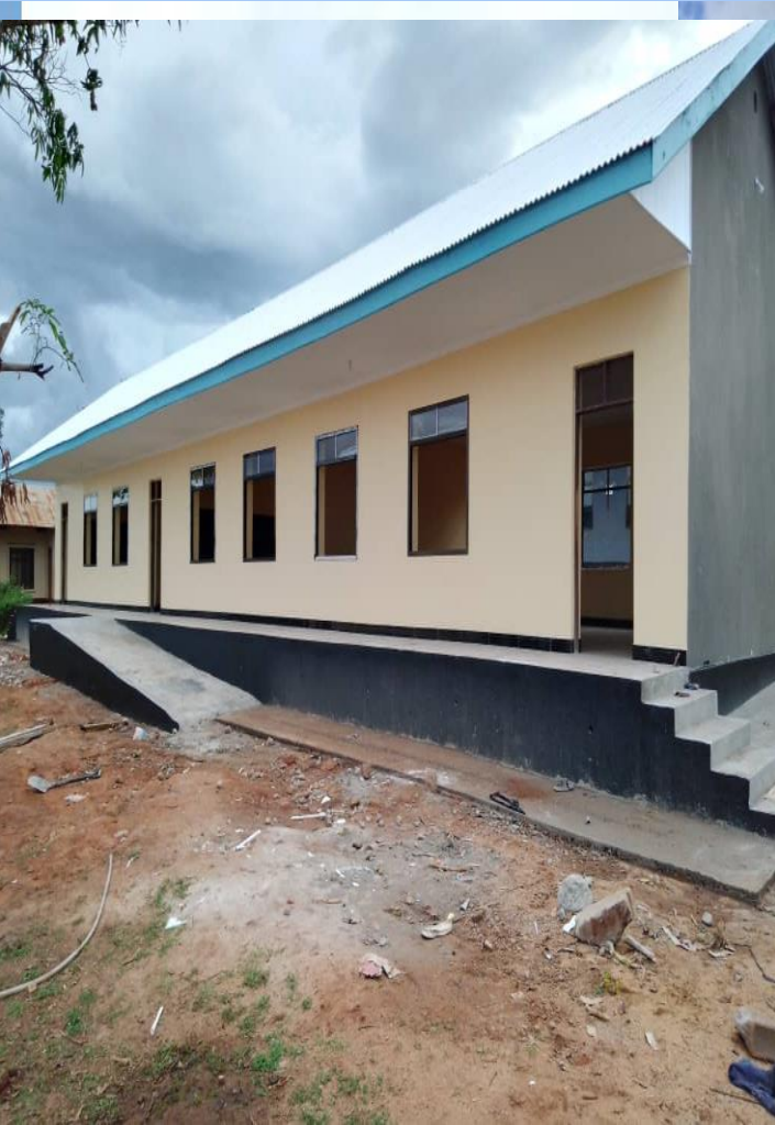
CHANDARUA SEKONDARI UJENZI WA VYUMBA 6 VYA MADARASA MIL.120,000,000
